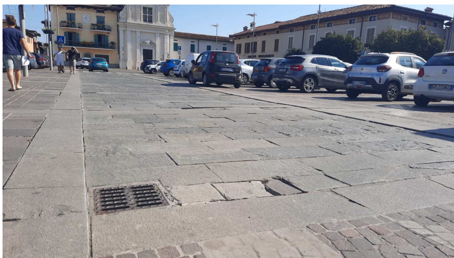
Pavimentazione Piazza Libertà prima dell'intervento
