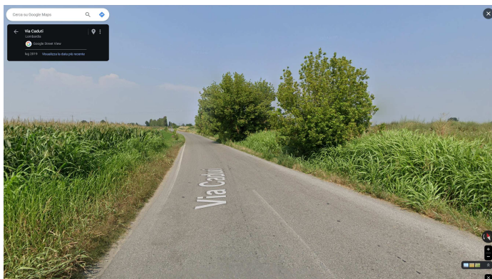
Via Caduti prima dell'intervento
