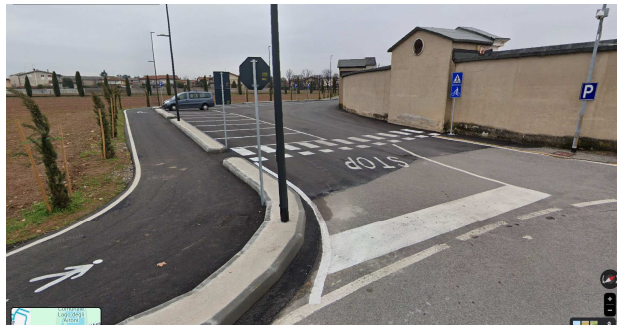
Parcheggio dietro cimitero dopo l'intervento
