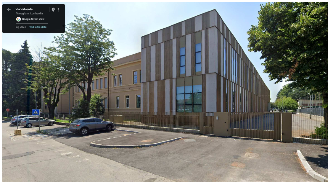
Scuola dopo l'intervento
