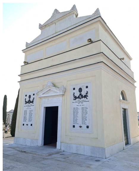
Qui a destra la chiesa dopo l'intervento di restauro
