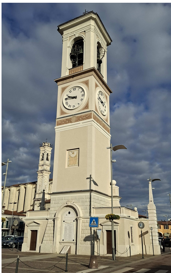
Questa la Torre Civica dopo l'intervento di restauro
