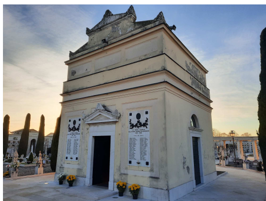
Questa la chiesa prima dell'intervento di restauro
