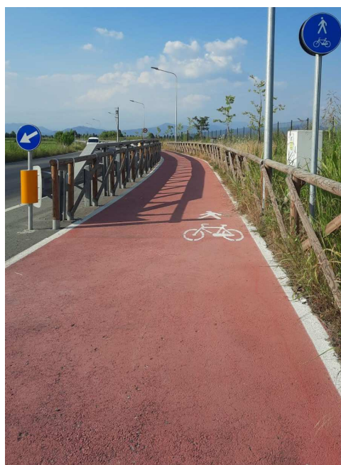
Via Caduti dopo l'intervento
